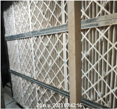
รูปที่ 3-41 การทำความสะอาดแผ่นกรองอากาศ
