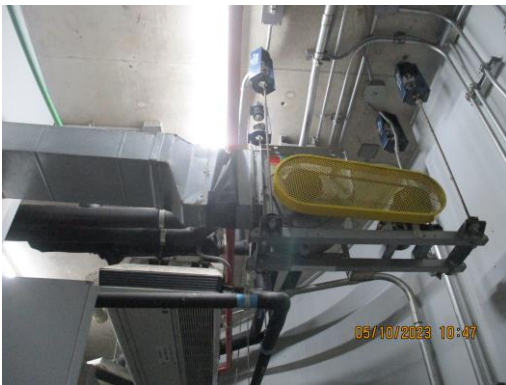
รูปที่ 3-14 พัดลมดูดอากาศในห้องพักมูลฝอยเปียก
