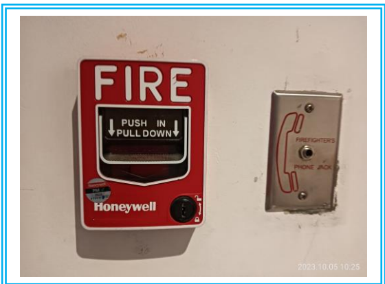
รูปที่ 3-57 เครื่องแจ้งเหตุโดยใช่มือดึง และกริ่งสัญญาณเตือนอัคคีภัย
