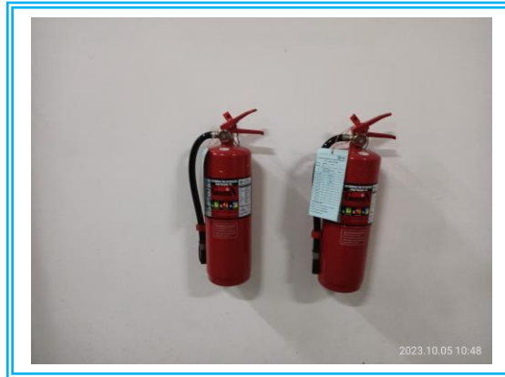
รูปที่ 3-52 ถังดับเพลิงมือถือชนิดคาร์บอนไดออกไซด์ (CO 2 )
