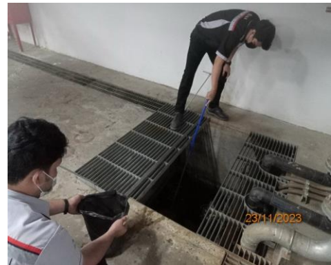
รูปที่ 3-73 ทำความสะอาดท่อน้ำทิ้ง
