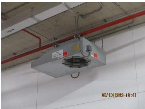
รูปที่ 3-7 พัดลมระบายอากาศบริเวณพื้นที่จอดรถ
