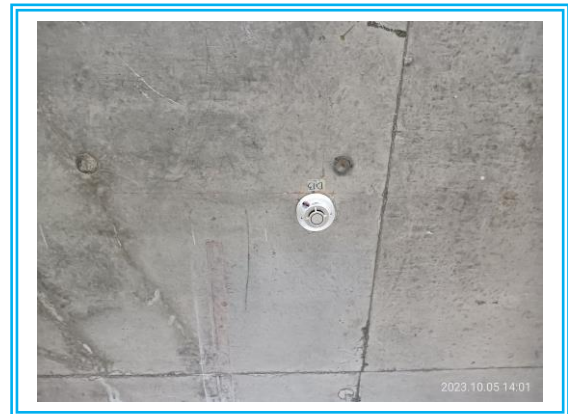
รูปที่ 3-56 เครื่องตรวจจับควันและความร้อน
